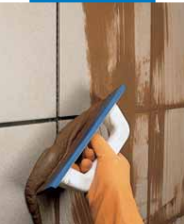
Затирка швов шпателем снаружи помещений
