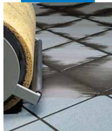
Машинная очистка плитки
