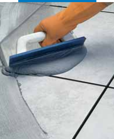
Заполнение швов в керамической облицовке полов при помощи резинового шпателя
