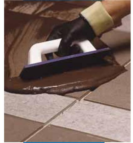
Заполнение швов составом Ultracolor Plus на полу с помощью резинового шпателя
