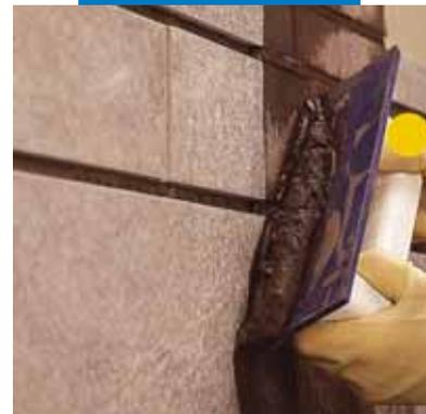
Заполнение швов на стене составом **Ultracolor Plus** с помощью резинового шпателя
